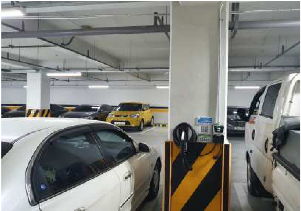
942동(LG연구동) 충전기 1대 설치
