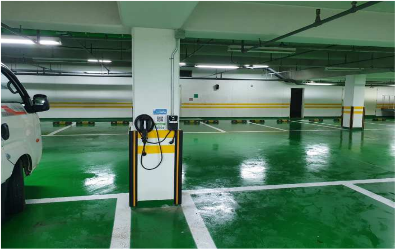
943동(SK연구동) 충전기 1대 설치
